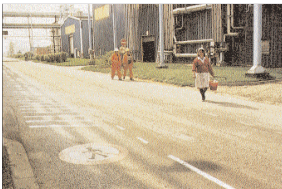
Voies de circulation
